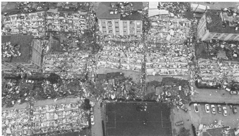
Рис. 3. Последствия землетрясения в Турции в 2023 г.
